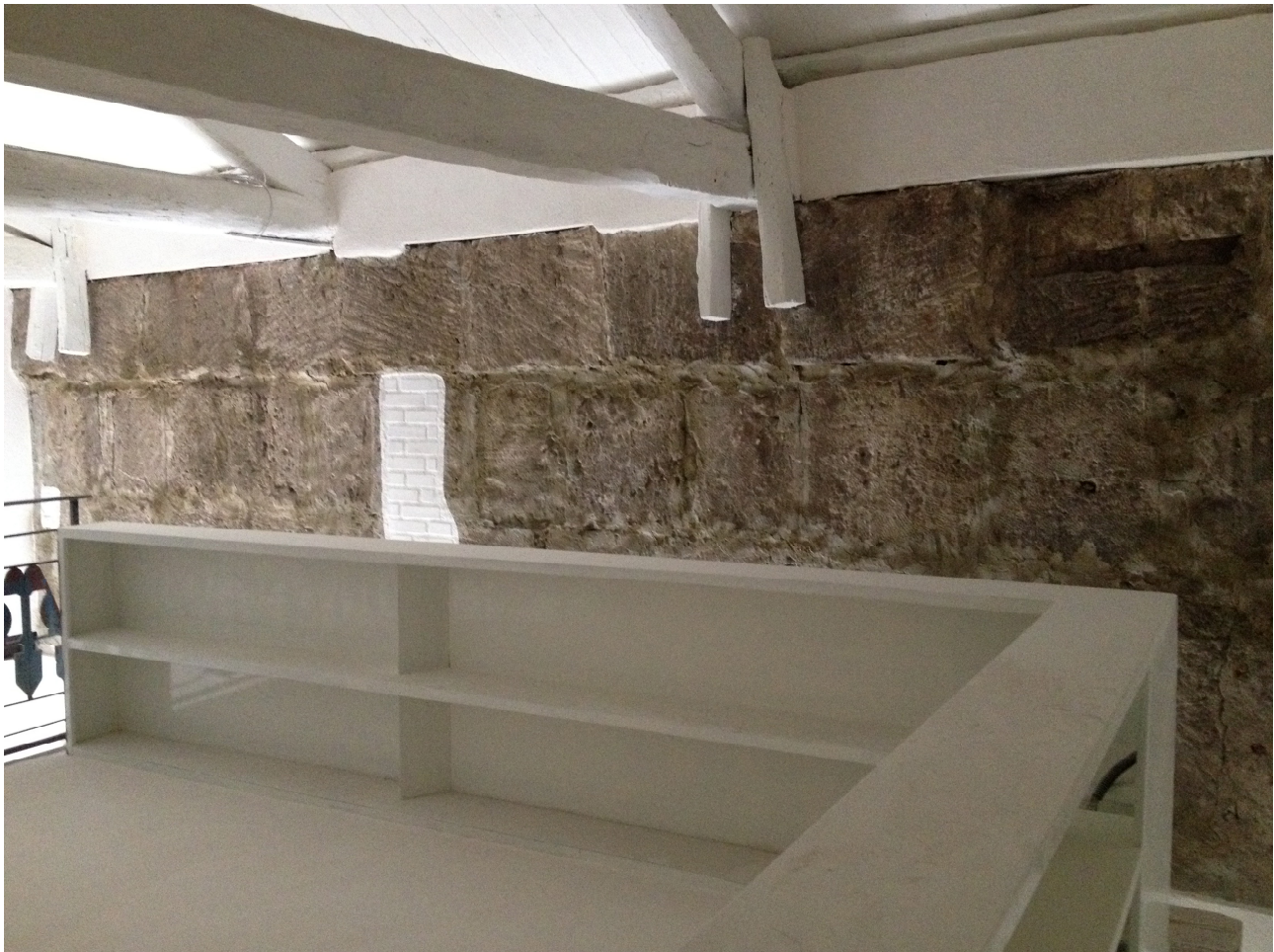
Fig. 9. Studiolo di ultimo impalcato – Il tetto esistente è stato trattato con calce viva, manna lasciate in natura viva le pietre d’Aspra perimetrali (con idoneo trattamento nanotecnologico di protezione). Foto E. W. Angelico.
