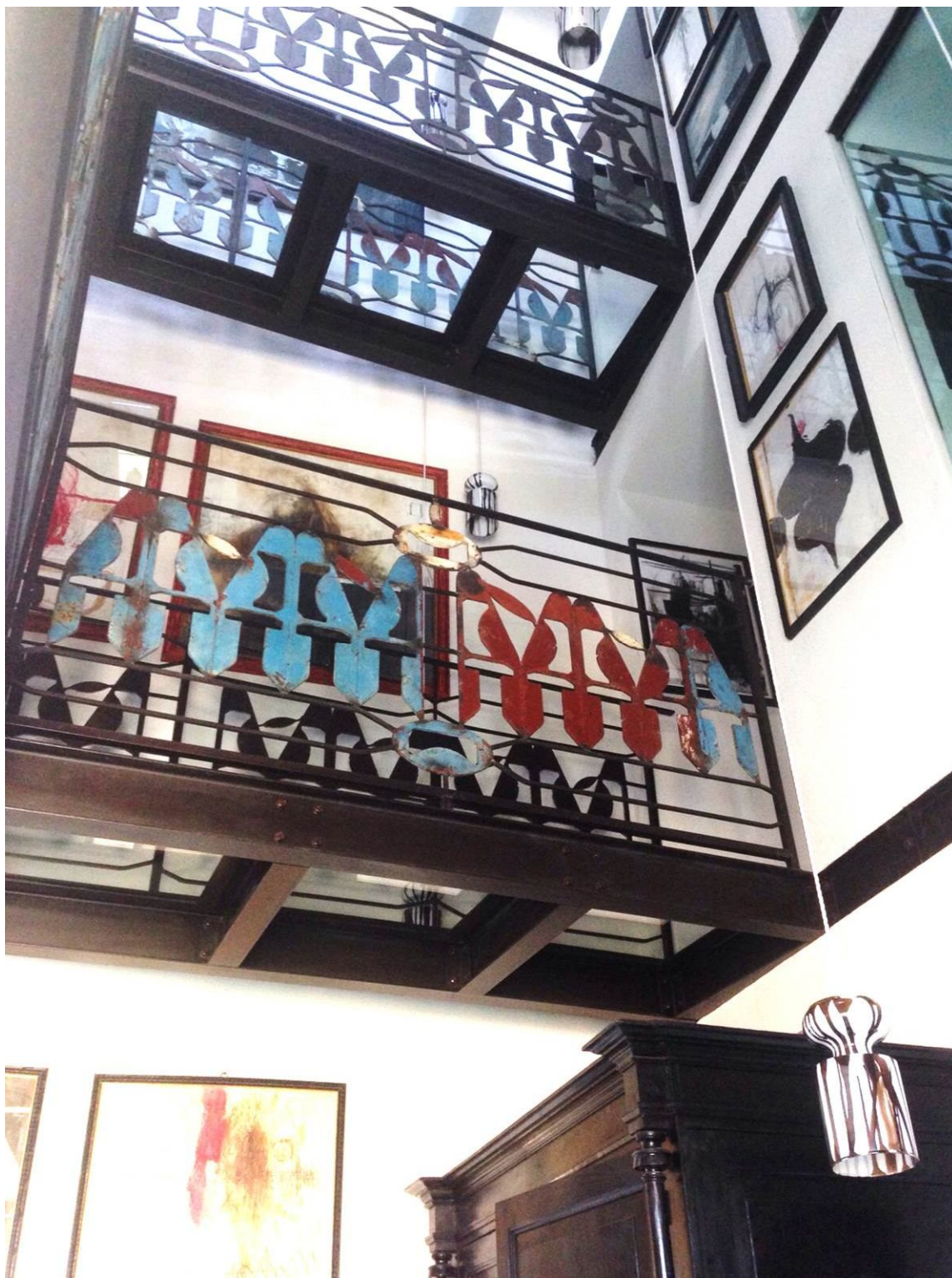
Fig. 7. Visti dal basso i vari livelli con le passerelle in acciaio e vetro. In evidenza i trovanti posti a complemento delle realizzazioni (di provenienza dello stesso stabile). Foto E. W. Angelico.
