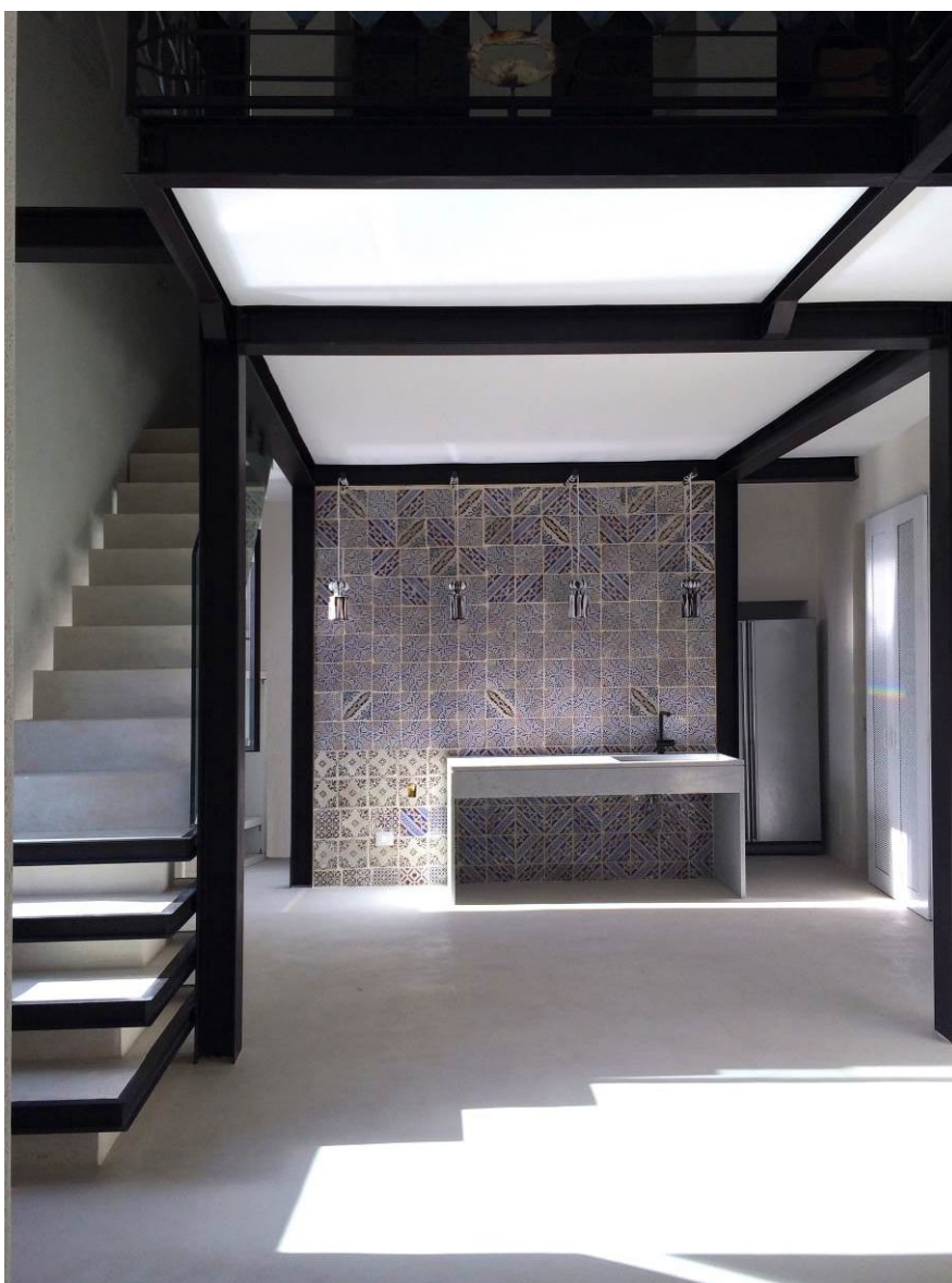
Fig. 6. La struttura a vista rigorosamente bullonata con la quinta dei servizi retrostanti realizzata con mattonelle maiolicate ritrovate nei sottotetti. Foto E. W. Angelico.
