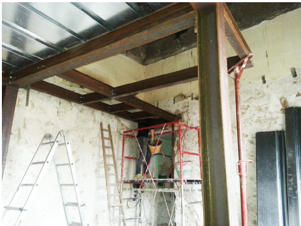
Fig. 3. Cantiere, montaggio degli impalcati a secco.
