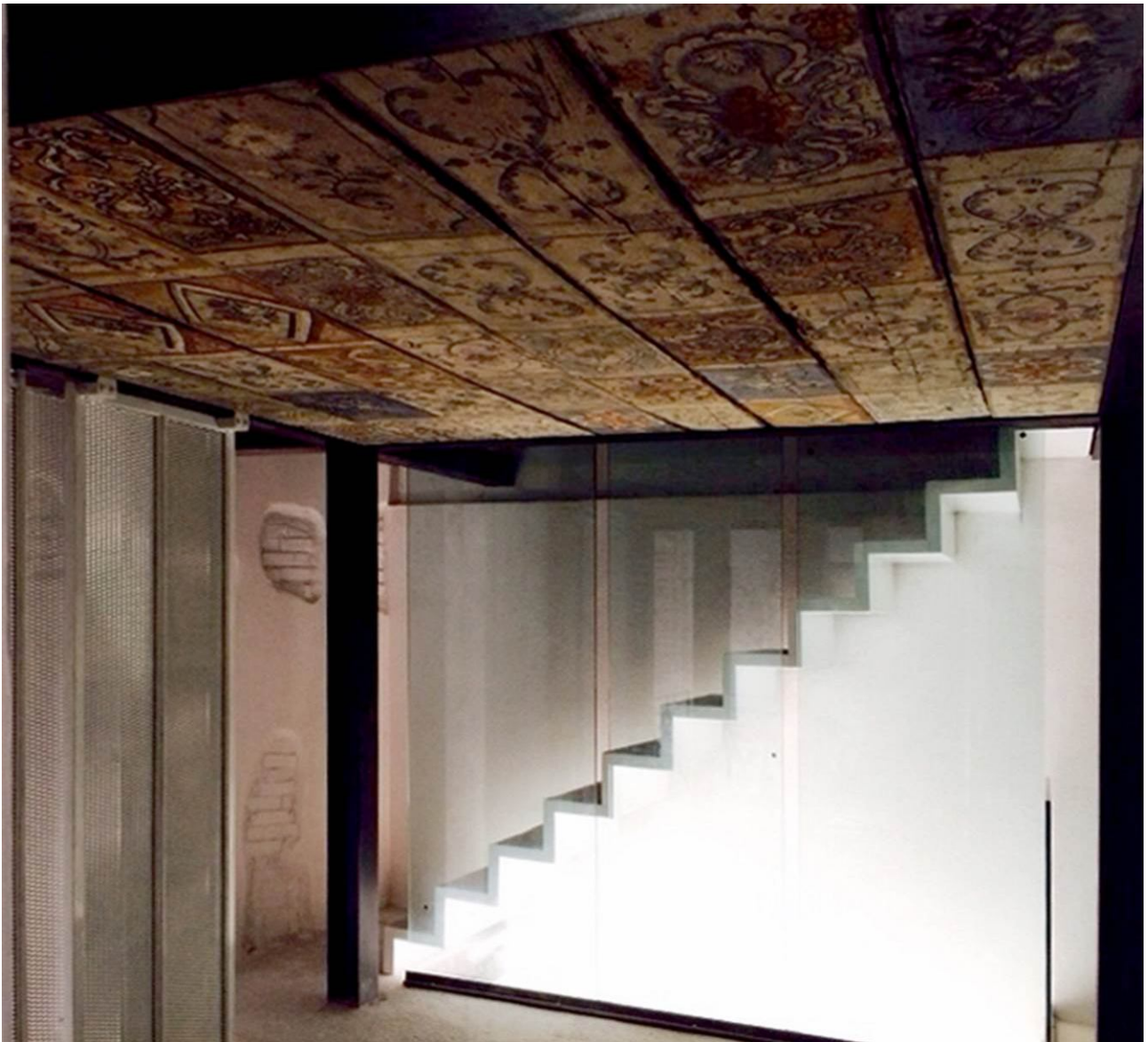
Fig. 8. Ambiente note - l'esilissima scala autoportante distaccata dalla parete, di connessione ai vari livelli. In copertura, I 'festoni' seicenteschi recuperati e rigenerati. Foto E. W. Angelico.
