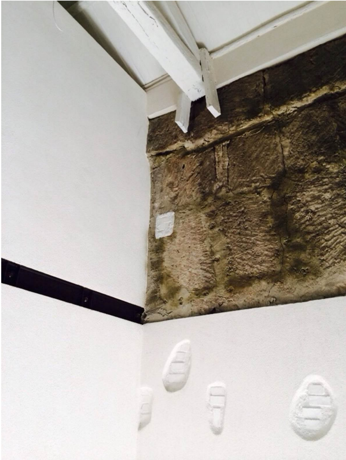
Fig. 10. Si sono lasciati volutamente a vista gli interventi di ‘cuci e scuci’ in rapporto con le altre materie utilizzare, a sottolineare con chiarezza gli interventi fatti. Foto E. W. Angelico.
